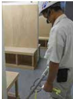
業務風景 ※工場で作成し、現地でのはめ込作業
