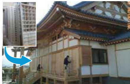
業務風景 ※工場で作成し、現地でのはめ込作業
