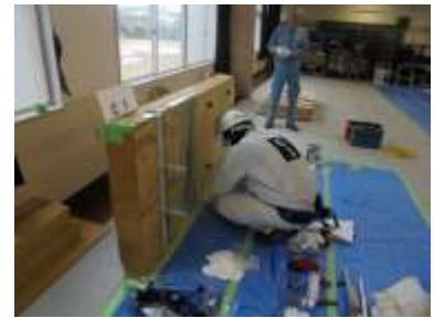
* 樹脂接着剤注入施工 *
